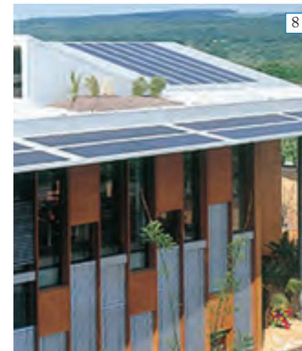
Fig.5 - Applicazione di pannelli fotovoltaici in film sottile
