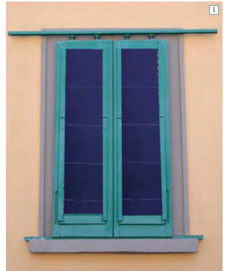
Fig 1 - Prototipo Persiana solare
